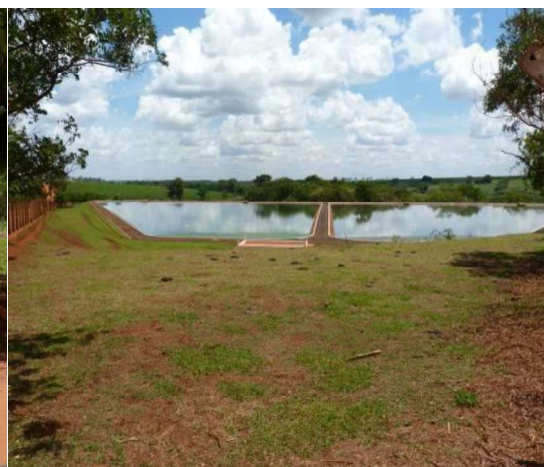
Figura 6. Sistema de lagoa facultativa da ETE.
